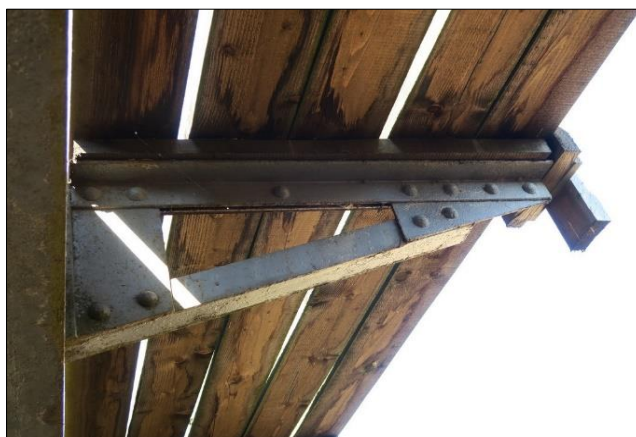
K01 - napojení chodníkové konzole vlevo.
