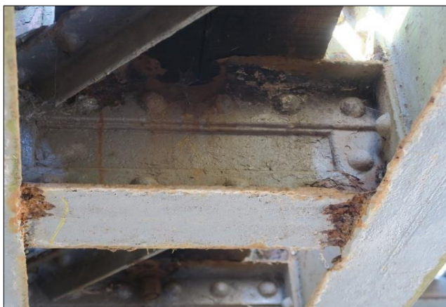
K01 - silně zkorodovaný horní a dolní úhelník stoličky č. 3 vlevo.
