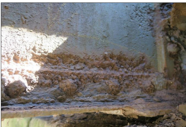
K01 - oslabená stojina a dolní úhelník nosníku č. 3 nad O 02.
