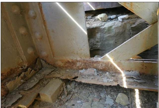
K01 - oslabení příčného ztužení na O 01 vpravo.
