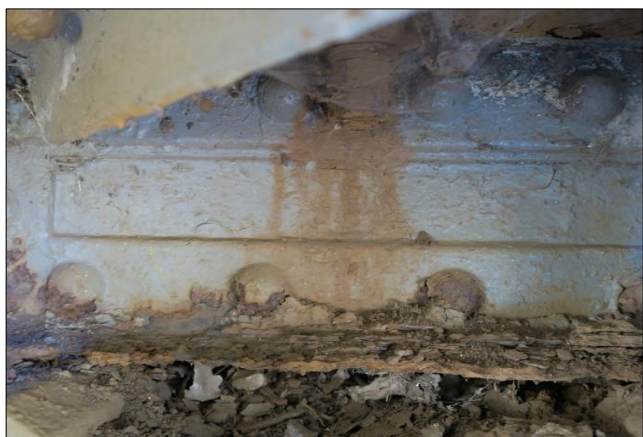
K01 - oslabení dolního úhelníku stoličky č. 7 vpravo.
